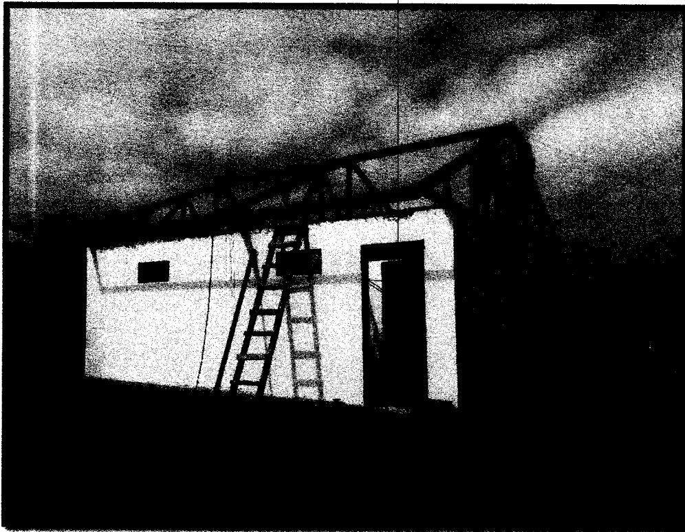
Zona del tópic. Se aprecia la colocación de tijerales, así como puertas y ventanas de madera.
